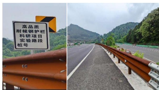
图 10 环保型免涂装高强高耐蚀公路护栏应用实例
